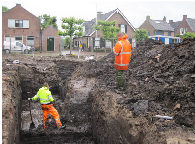
Afbeelding 14: Overzichtsfoto van de werkput.
